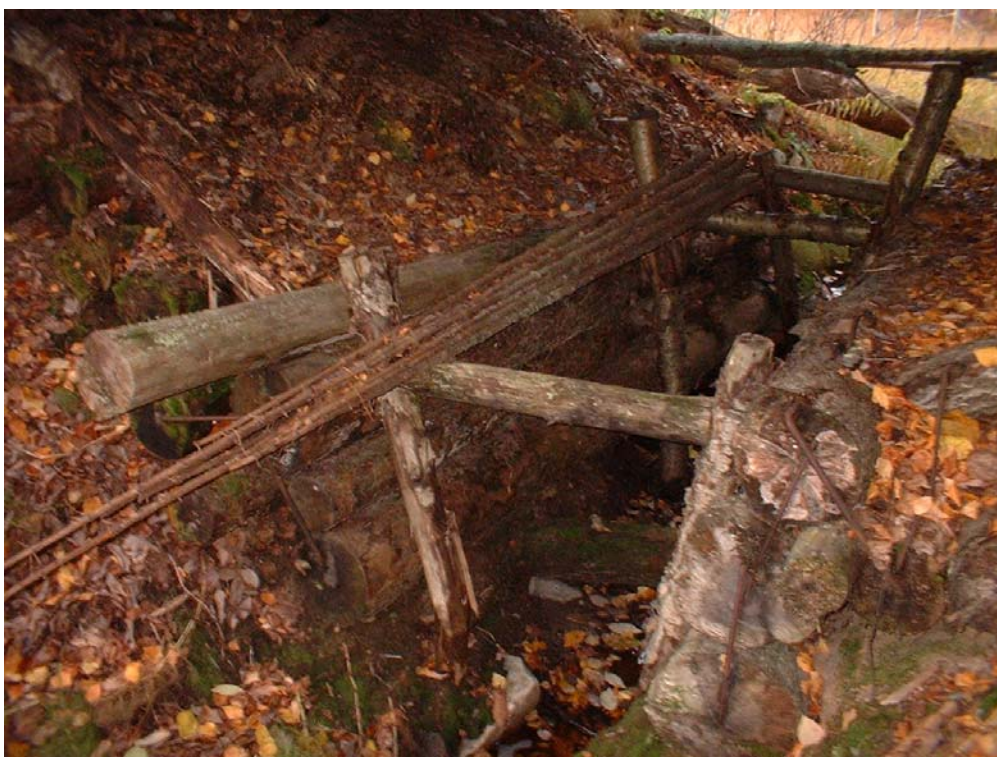
Фото № 28. Деревянная конструкция моста при большой высоте насыпи.
