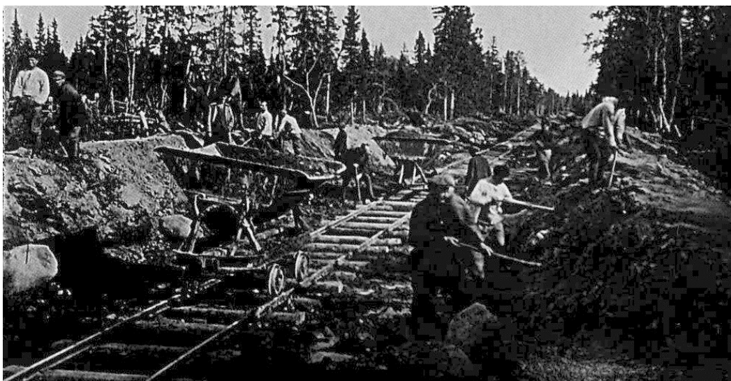
Фото № 24. Строительство новых железнодорожных веток. Фото до 1928 г.
