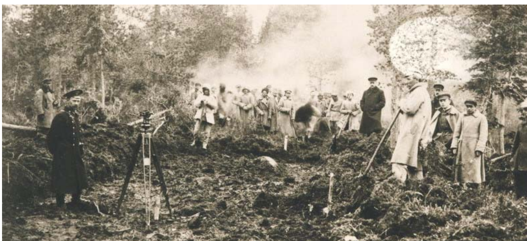
Фото № 23. Прокладка в лесу просеки для железнодорожной линии. Фото до 1925 г.
