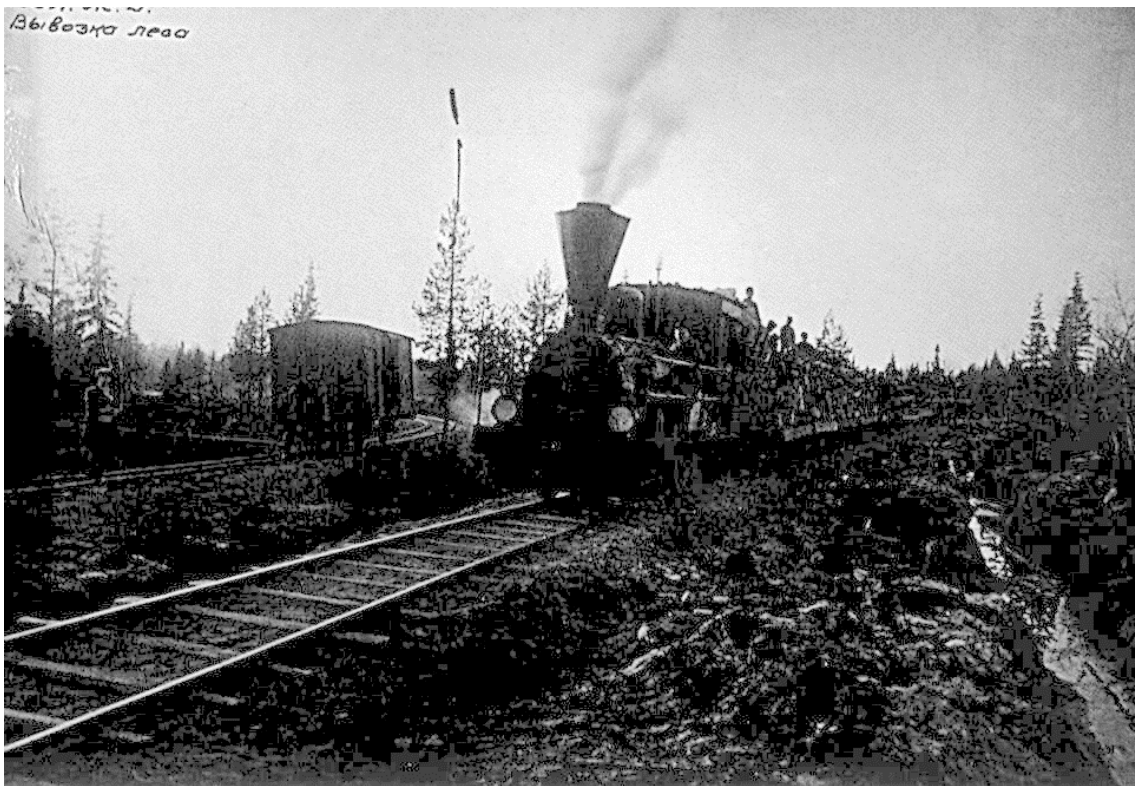
Фото № 21. Железнодорожные составы на паровой тяге. Фото до 1928 г.
