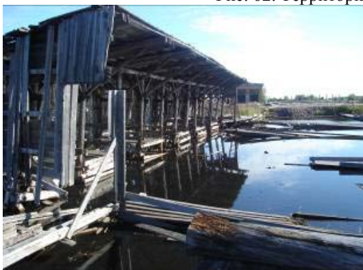
Рис. 63. Территория Лесозавода. Фото 2012 г.
