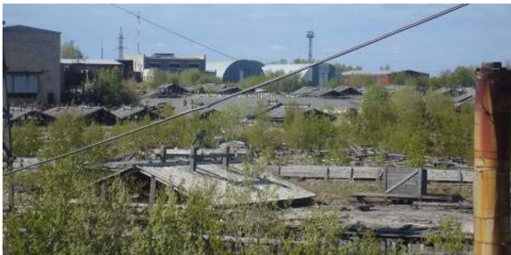
Рис. 55. Территория Лесозавода. Фото 2012 г.
