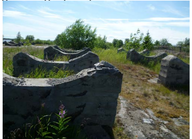
Рис. 40. Фрагменты бетонных конструкций. Фото 2011 г.
