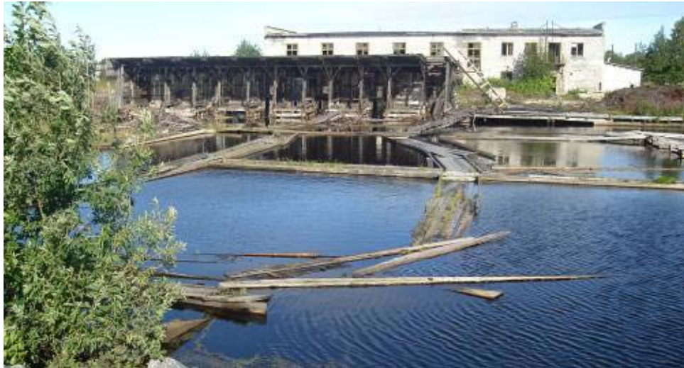
Рис. 60. Территория Лесозавода. Фото 2012 г.
